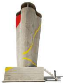
Chimenea del edificio de Le Corbusier, intervenida por el artista Felice Varini. / S. SÁNCHEZ
